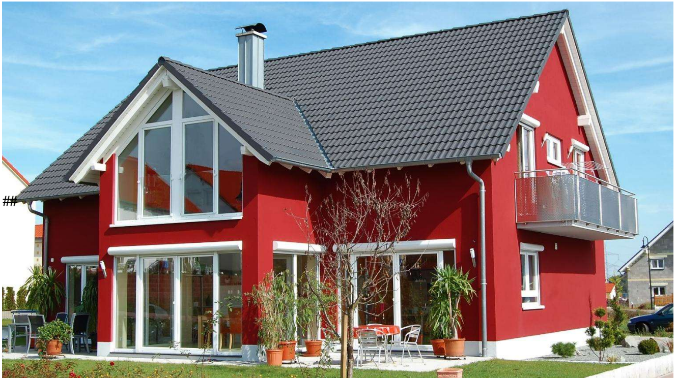
Blick auf die Doppelhaushälfte in Blickrichtung Südwesten
